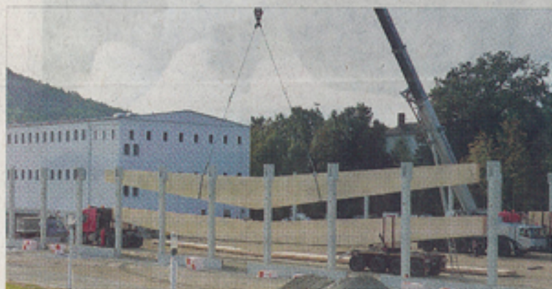
Ankunft der ersten Dachbinder am frühen Morgen.
